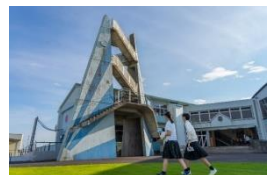
<震災遺構 浪江町立請戸小学校>
